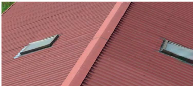
Pannelli sandwich isolpack (D5 - in alto - SUPERCOPPO in basso)
